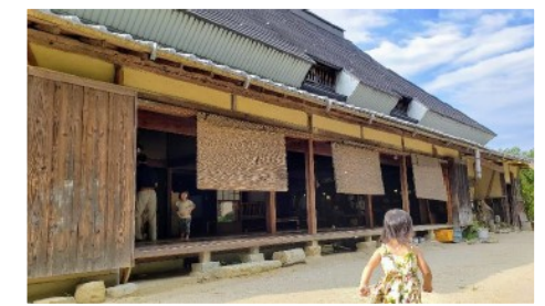
移設した古民家
